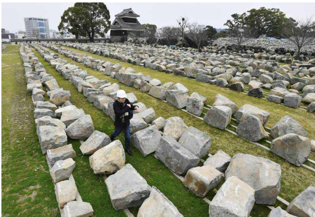
Рис. 14. Замок Кумамото во время реставрации. Камни выложены в том порядке, в котором их нужно будет собрать заново в виде стен
